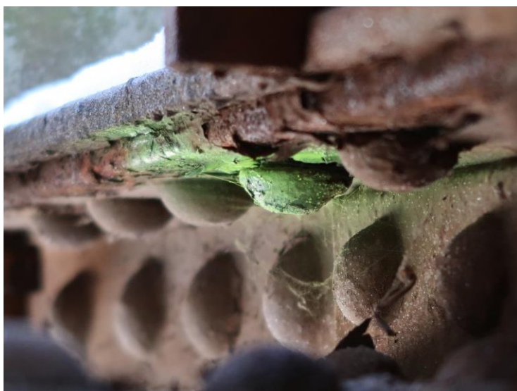
Foto č. 2 Konstrukce K 01 – levý podélník, 9 příčník – volný nýt
