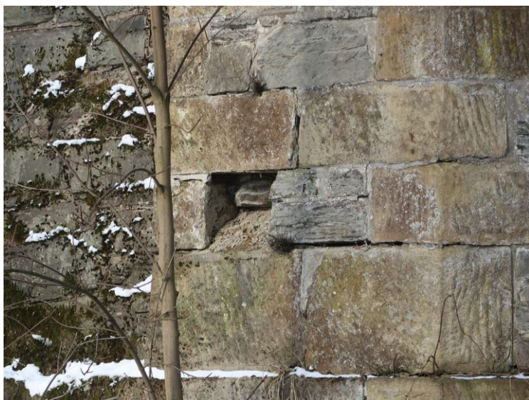
Foto č. 3 Opěra O 01 –vpravo – vypadnutý kámen
